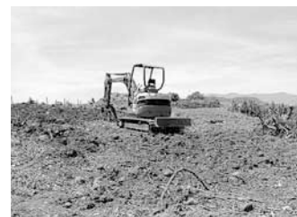
再生作業(重機利用)
