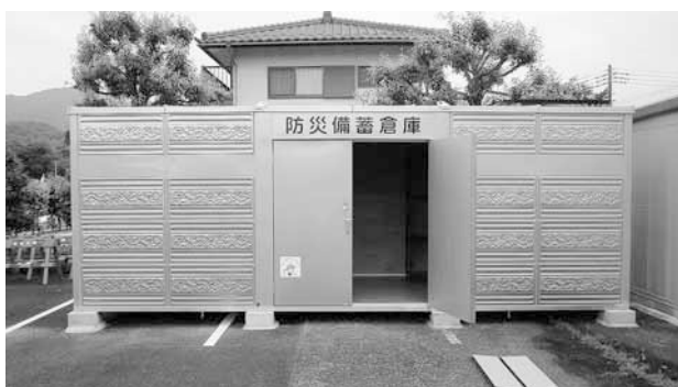
設置場所：南部医療センター駐車場内
