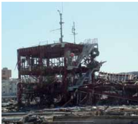
骨組みだけの防災対策庁舎
