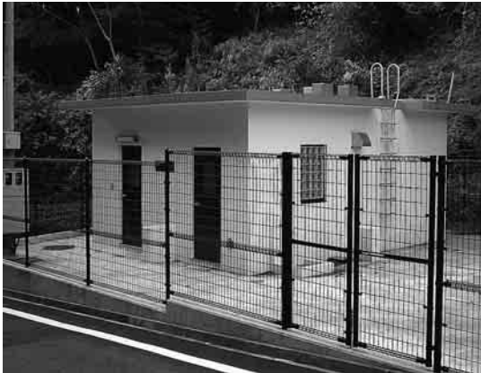
17年度完成の八木沢小規模水道施設
