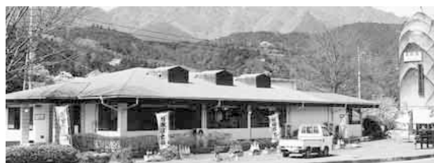
改修予定の道の駅
