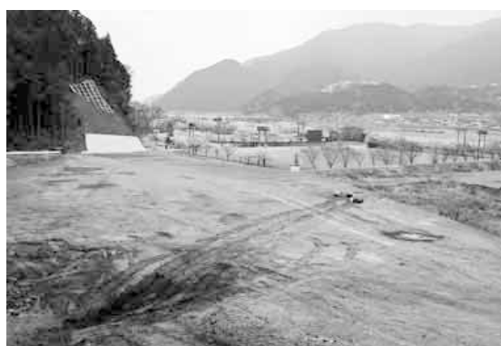
火葬場建設予定地
