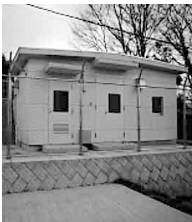
平成16・17年度事業で水道整備を実施した、屋敷平・杉山地区が4月から町営水道になりました。 陵草(屋敷平・杉山)が 町営水道に
