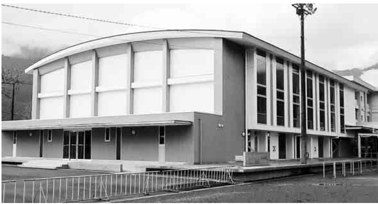
鉄骨造平屋建て 総床面積866.5㎡ アリーナ1面（30m×22m）
