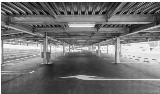
立体駐車場1階
