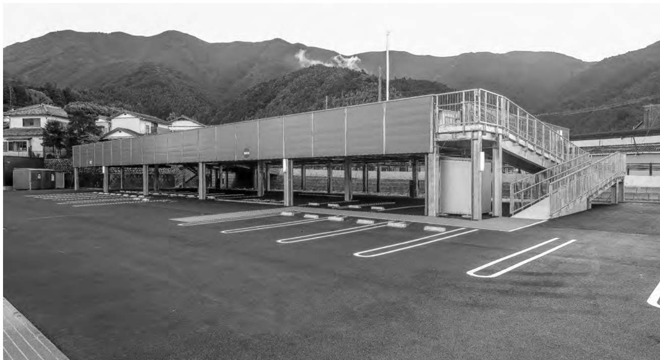
立体駐車場外観南西側
