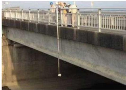
写真 5.1.1 現場での点検作業に対する新技術（例：ロボットカメラ）
