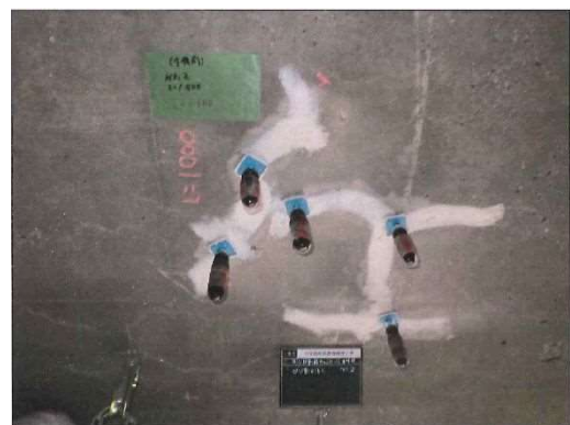
写真-2 補修状況（ひびわれ補修）
