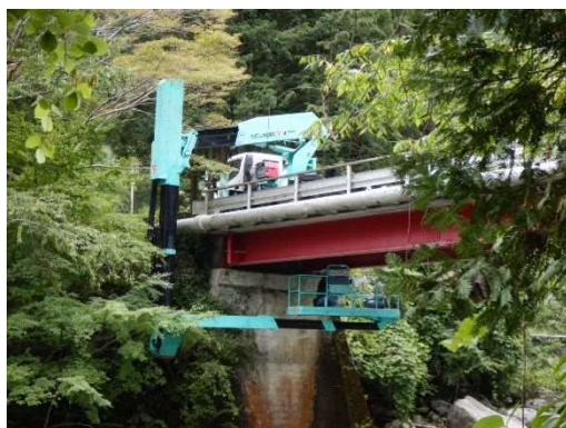
写真-1 点検状況
