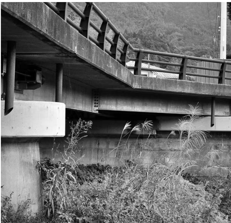
落橋防止工事が完了した月見橋（本郷）
