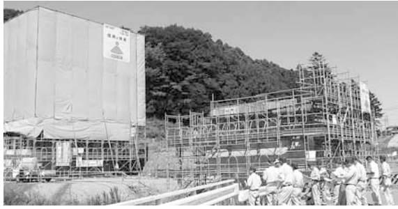
中部横断道工事現場
