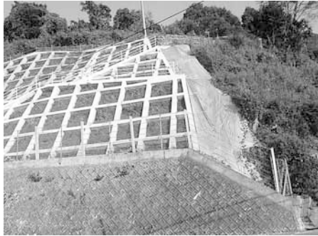
急傾斜地対策事業 (内船地内)
