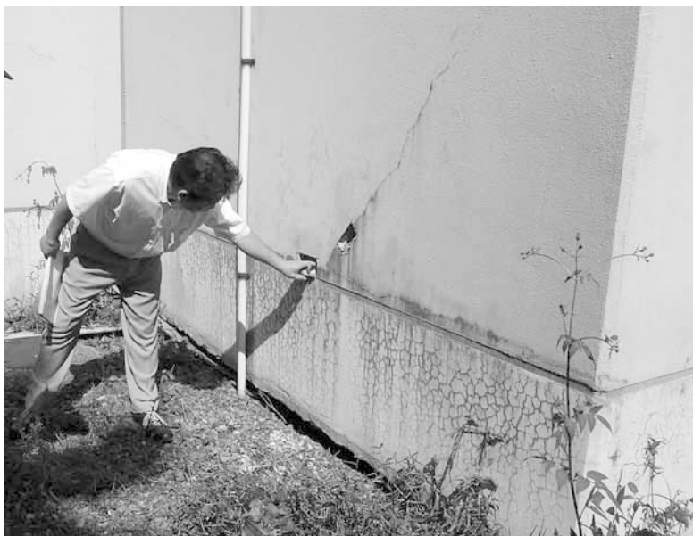
アルカディア体育館外壁
