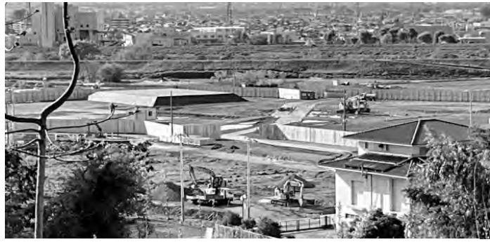
造成中のゴミ処理施設（中央市内）
