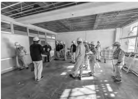
改修中の教室
