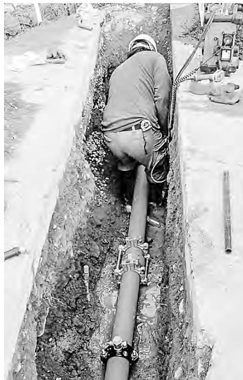
本管取替工事
