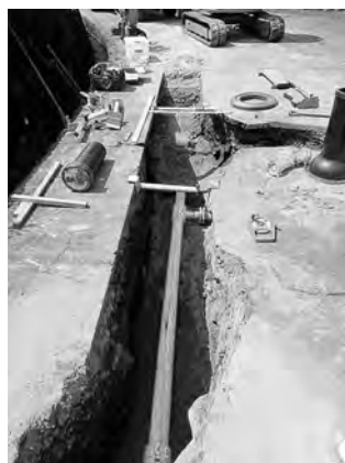
徳間配水管敷設替工事
