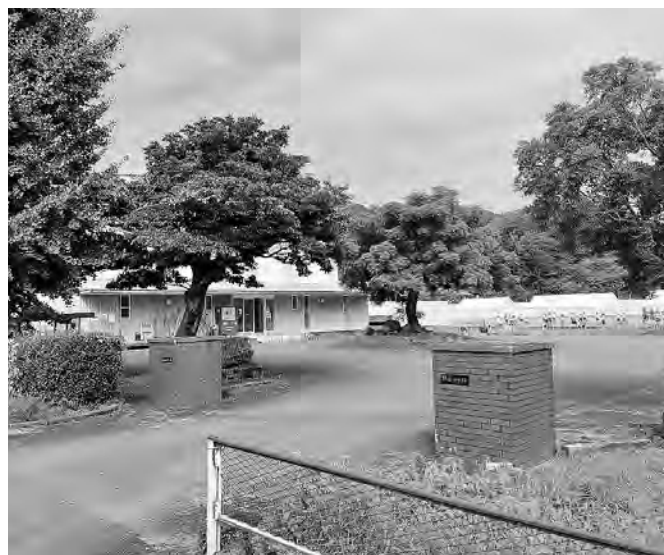
睦合小学校外構工事予定地
