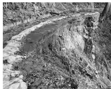
林道復旧予定地
