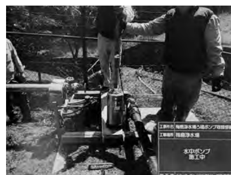
水道機械修繕
