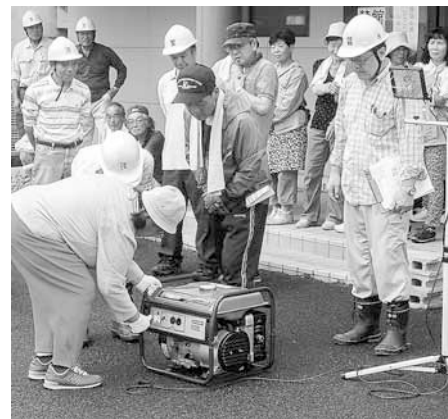
発電機操作訓練
