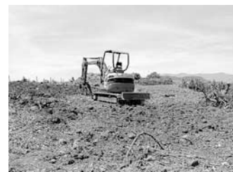
再生作業(重機利用)
