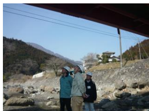
学識経験者との現地踏査
