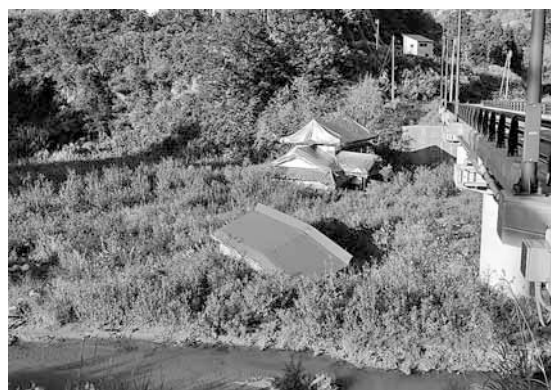
土砂に埋れた道路と住宅
